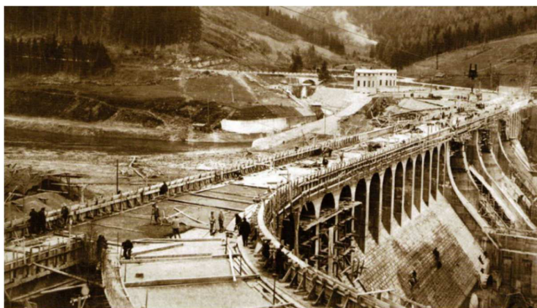
Rysunek 10.1. Porąbka – widok zapory, prace budowlane na koronie
