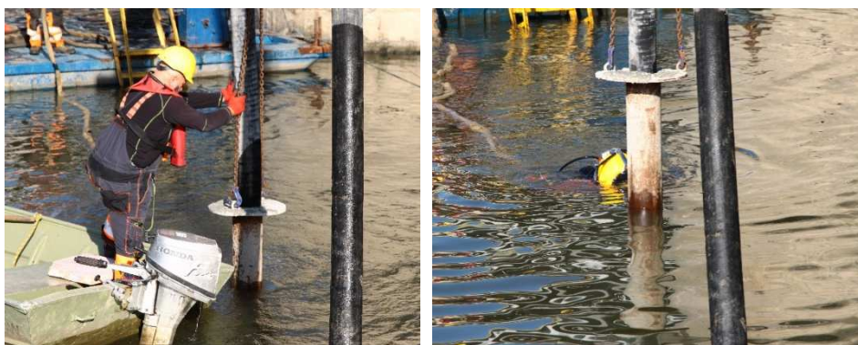
Rysunek 9.3. Betonowanie zasadnicze metodą kontraktor
