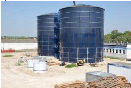
Fig. 5.4. Closed fermentation chambers: a) cylindrical, ( http://www.jrp.mpgk.chelm.pl/aktualnosci/zamknite-komory-fermentacyjne ), b) egg shaped ( http://e-czytelnia.abrys.pl/wodociagi-kanalizacja/2013-12-725/oczyszczanie-sciekow-8442/oczyszczalnia-sciekow-stabilizacja-osadow-cz-v-17515 )
