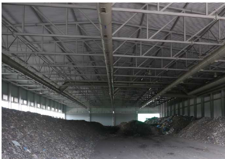
Fig. 5.13. Compost pile composting plant ( https://www.aknova.com.pl/pl/Podstrony/Realizacje/Wykonawstwo/Kompostownia-w-RZGO-S-ajsino )
