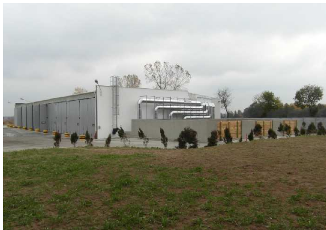
Fig. 5.15. View of the composting chambers ( https://www.aknova.com.pl/pl/Podstrony/Realizacje/Wykonawstwo/Kompostownia-w-zak-adzie-CHEMEKO-SYSTEM-m-Rudna-Wi )
