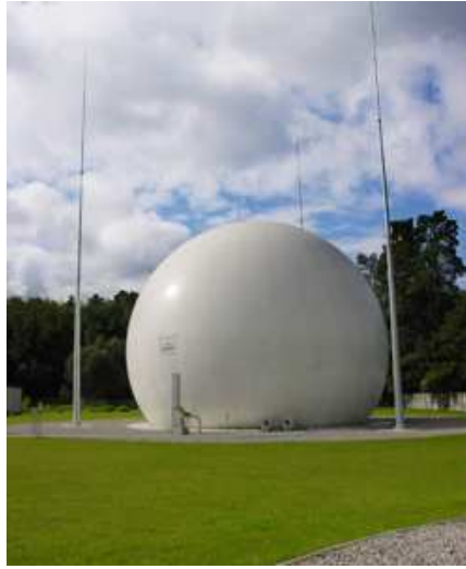
Fig. 5.8. Biogas tank ( http://www.sigatech.pl/pl/oferta/wyposazenie-sieci-biogazu/zbiorniki-magazynowe-biogazu.html )
