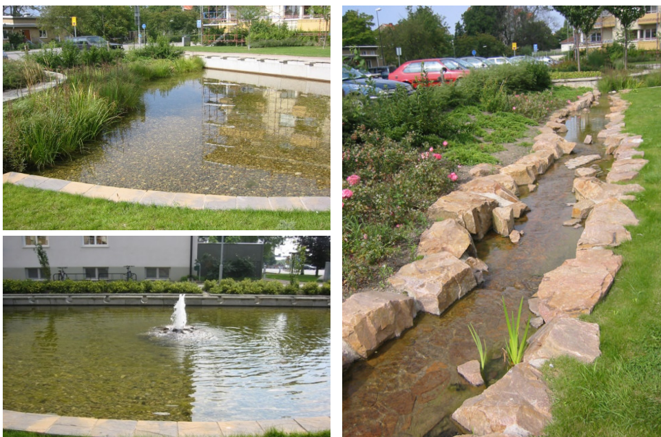
Rys. 2.5. Przykład wykonania otwartego systemu odprowadzania wód opadowych w dzielnicy Augustenborg w Malmö (fot. autor)
