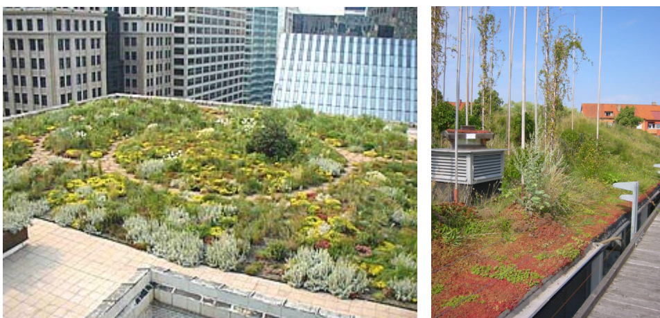
Rys. 2.2. Przykłady zastosowania zielonych dachów w budownictwie miejskim: a) dach Chicago City Hall, b) instalacja pilotażowa w Augustenborg (Malmö) (fot. autor)
