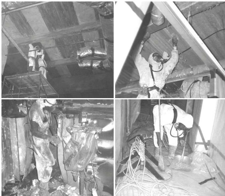
Rys. 19.3. Bezpieczne usuwanie azbestu w pomieszczeniach zamkniętych wg [38]
