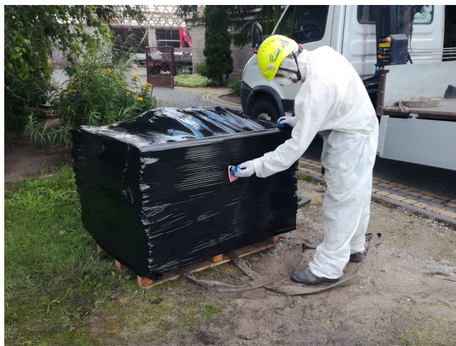
Rys. 19.5. Zabezpieczanie odpadów zawierających azbest do transportu [65]
