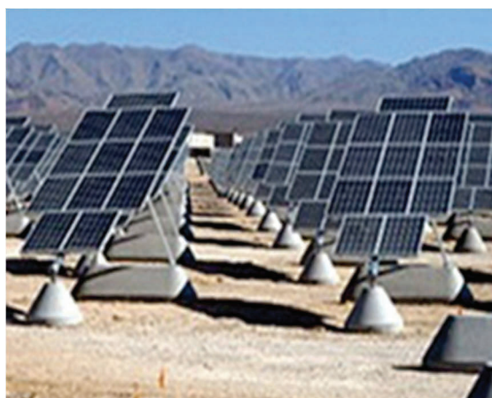
Rys. 5.10. Pionowy, jednoosiowy system nadążny [13]
