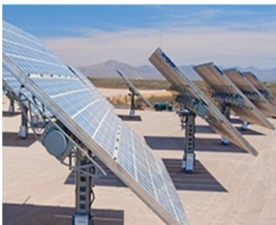
Rys. 5.11. Dwuosowy system nadążny [13]
