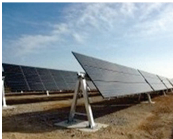
Rys. 5.9. Poziomy, jednoosiowy system nadążny SAT [12]
