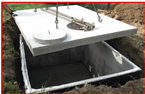
Rysunek 20.1. Zbiorniki bezodpływowe: betonowy oraz poliestrowy ( http://www.budujemydom.pl/... )
