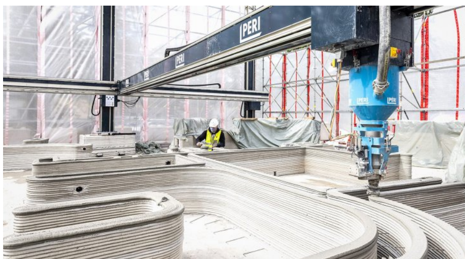
Rysunek 18.1. Proces drukowania ścian metodą Contour Crafting (CC)
