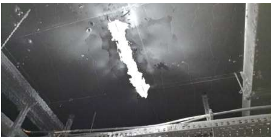
Fot. 2.4. Miejsce pobrania próbki zbrojenia dolnego płyty stropowej
