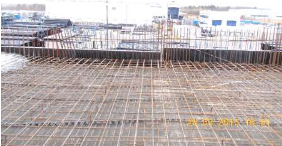
Fot. 1.3. Belka obwodowa oraz strop w osiach C-D/6-7
