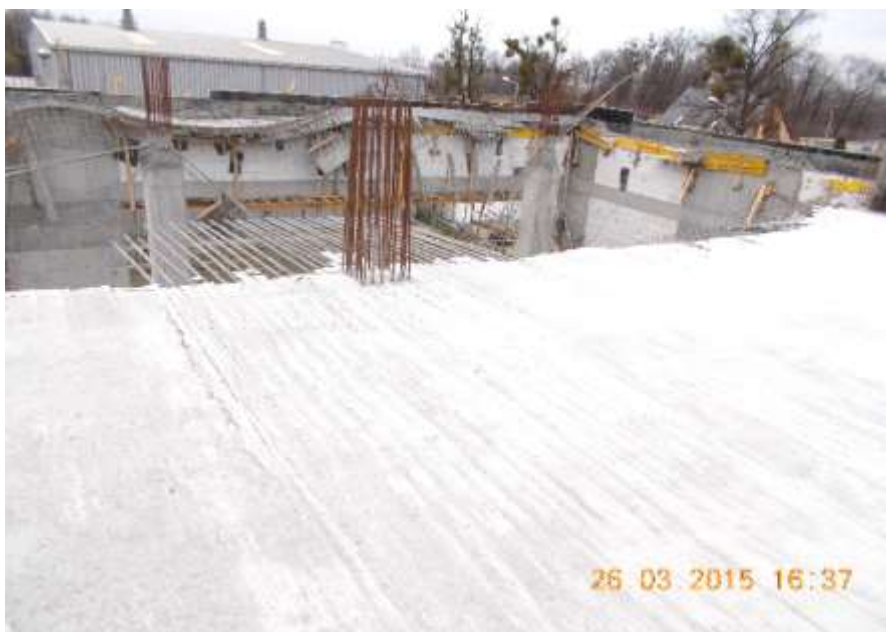
Fot. 1.6. Płyta stropowa w osiach C/8-12
