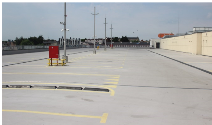
Rys. 1.3. Posadzka na dachu parkingu wielopoziomowego
