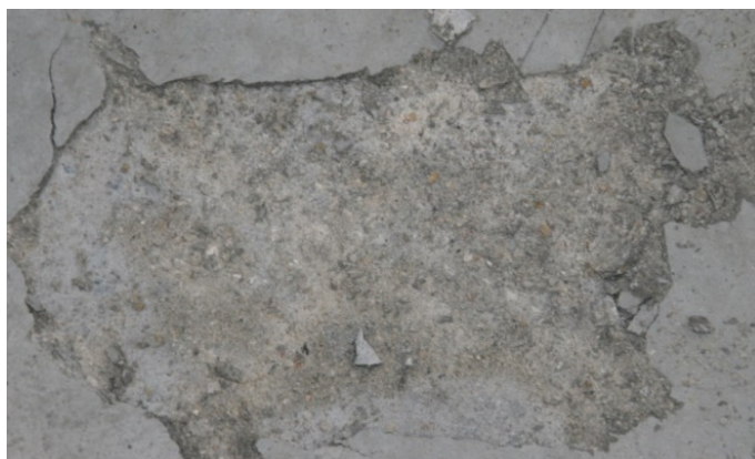
Rys. 1.19. Lokalne odspojenie warstwy utwardzonej grubości 5-10 mm
