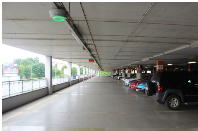
Rys. 1.2. Posadzka kondygnacji pośredniej otwartego parkingu wielopoziomowego
